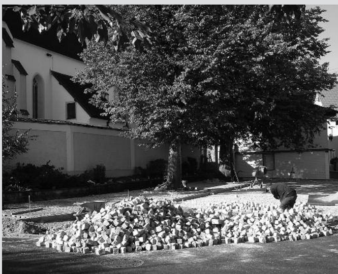
Bauarbeiten im Ortszentrum
