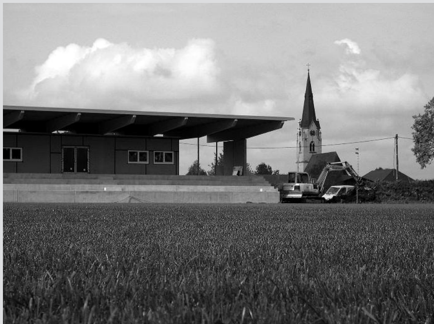
Nach Abschluss der Bauarbeiten beim Fußballfeld wird jetzt bis zum Frühjahr die Tennisanlage und der Beachvolleyballplatz gestaltet.
